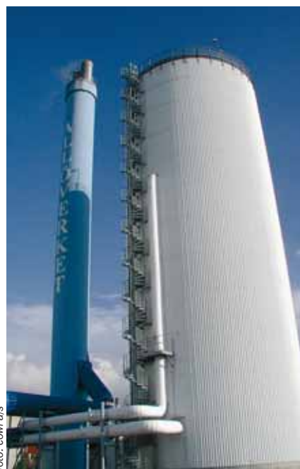
Skorsten og akkumuleringstank på det træfyrede Allöværk i Kristianstad. Bemærk røgfanen, der er næsten usynlig, da en meget stor del af vanddampen uddrives ved opfugtning af forbrændingsluften.
