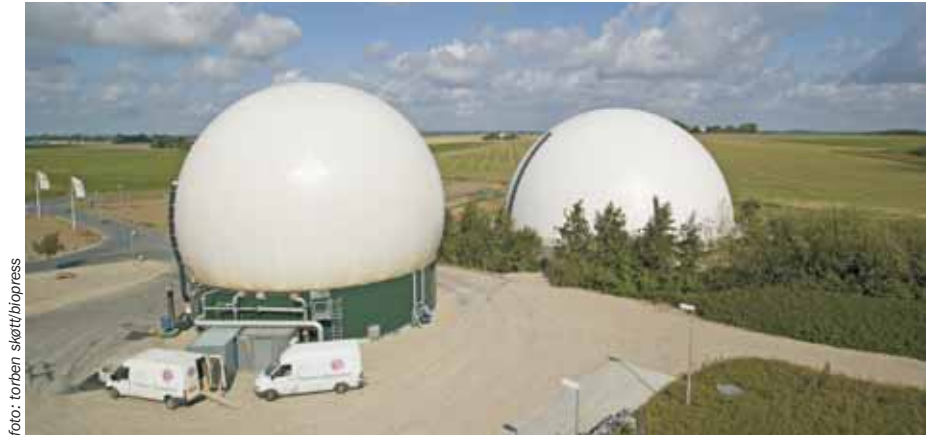
Biogaslægget i Hashøj råder over to gaslagre, der tilsammen kan dække forbruget i cirka et døgn.
