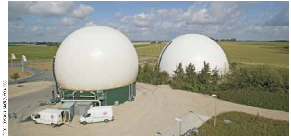
Biogaslægget i Hashøj råder over to gaslagre, der tilsammen kan dække forbruget i cirka et døgn.
