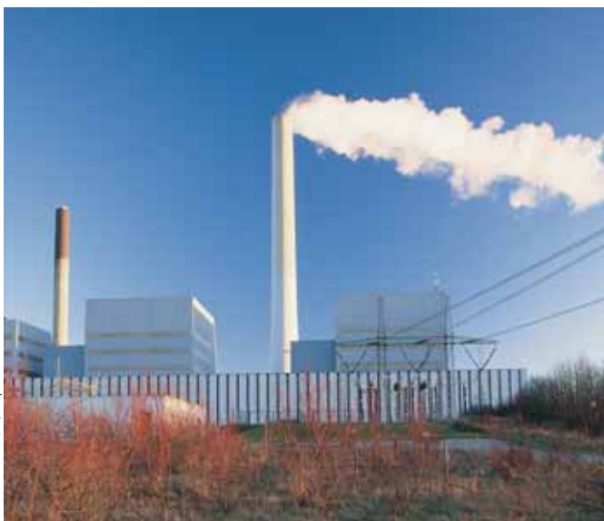
Studstrupværket ved Århus.
