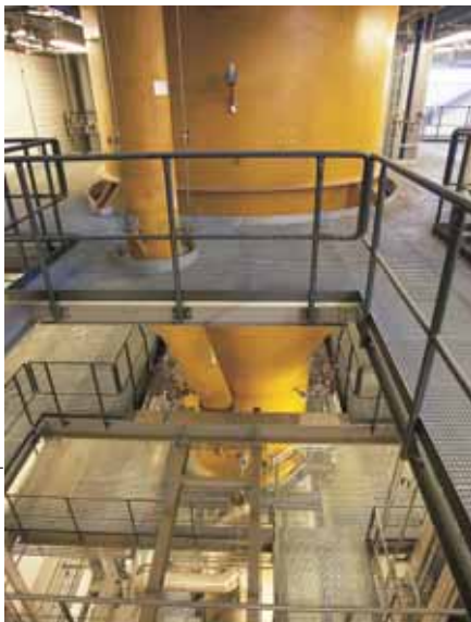
Forgasseren hos Skive Fjernvarme, hvor træpiller omsættes til gas.
