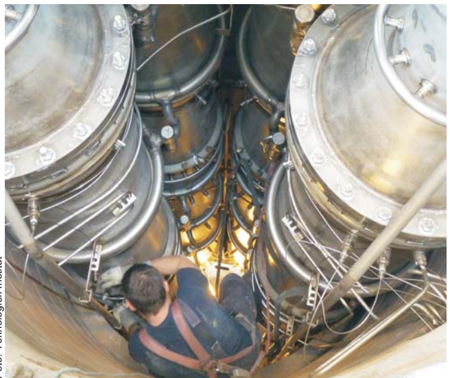
Installation af reaktorrør hos Skive Fjernvarme.
