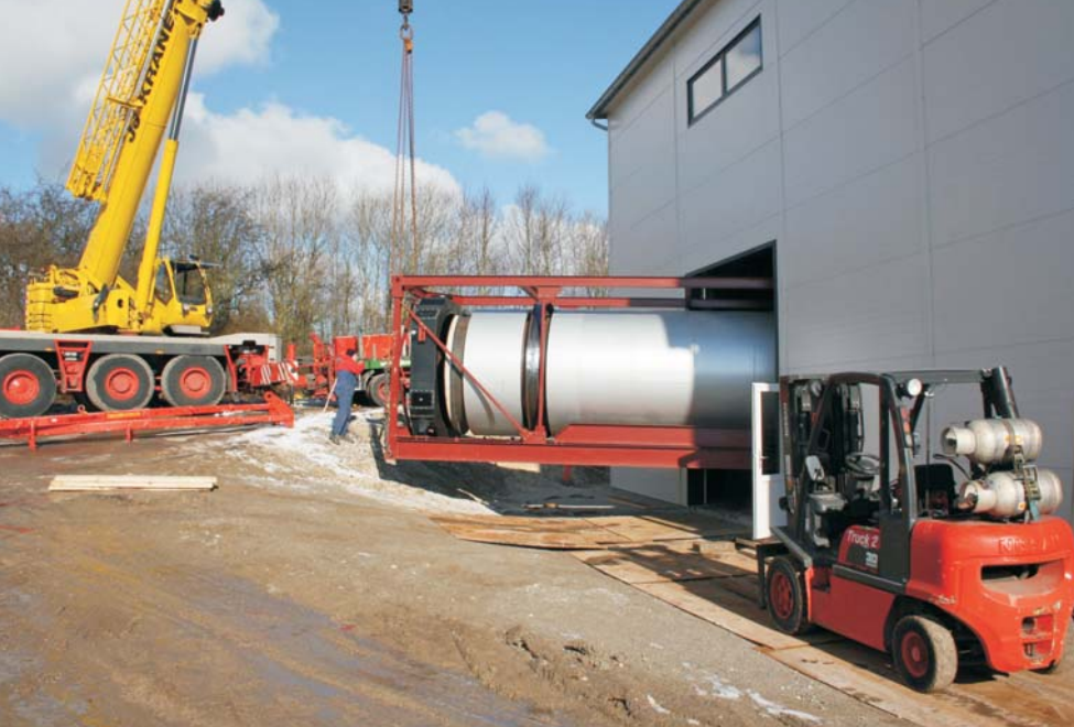
Til venstre: Tørreanlægget løftes på plads i Hillerød. Store dele af anlægget er modulopbygget, så det kan flyttes. Til højre: Henrik Houmann Jakobsen ved anlægget i græsted, der producerede gas i 6.000 timer, heraf 4.000 timer hvor motoren var i drift, og der blev leveret el til nettet. Foto: Torben Skøtt.
