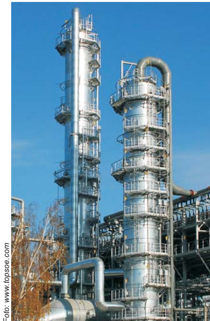
Anlæg til fremstilling af metanol i Iran, designet af Haldor Topsøe.
