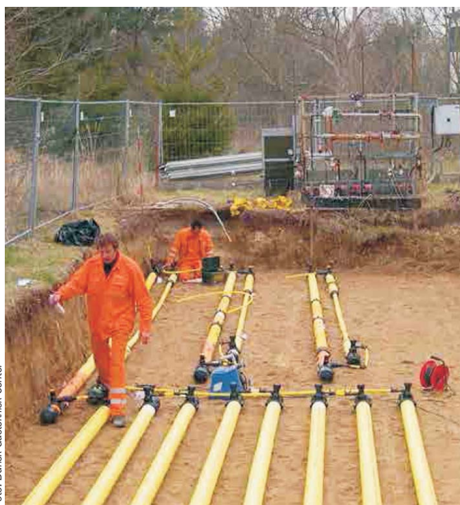
Anlægget blev udformet som et mini-distributionsnet.
