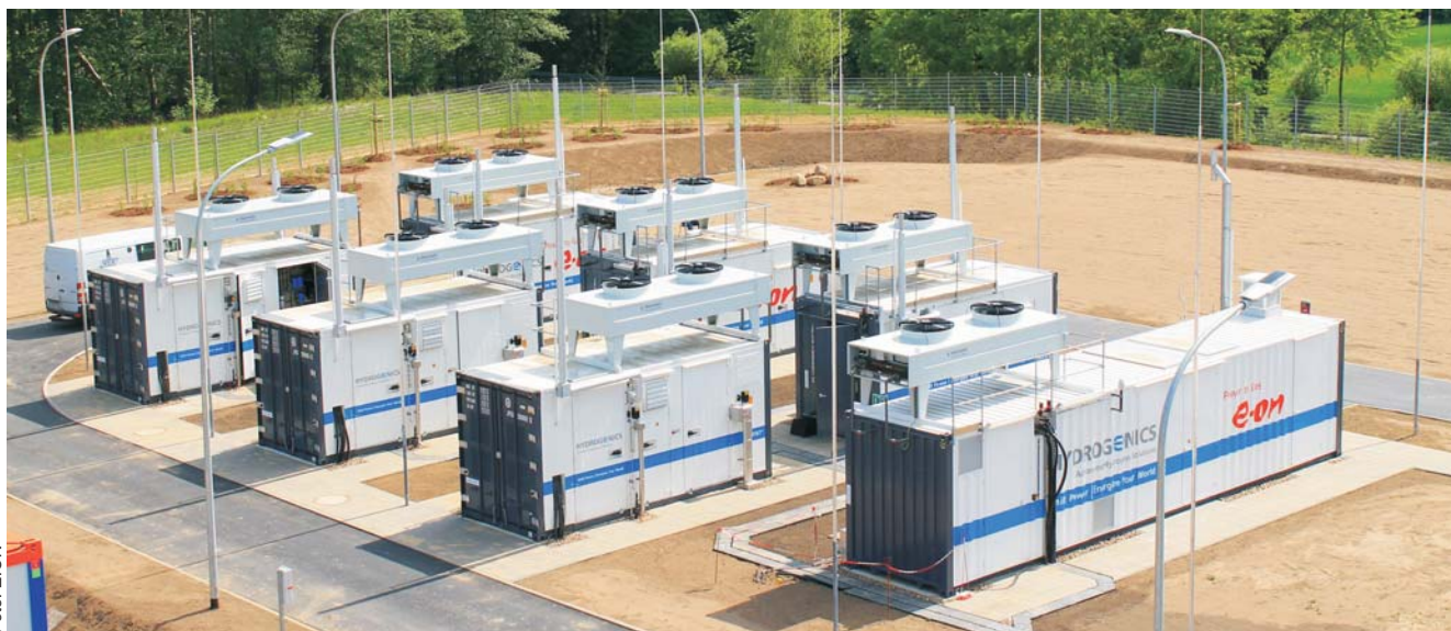
Elektrolyseanlæg i Falkenberg i Tyskland, hvor vindmølle-el konverteres til brint og pumpes direkte ind i naturgasnettet. Anlægget har en effekt på 2 MW og kan producere 360 m 3 brint i timen.
