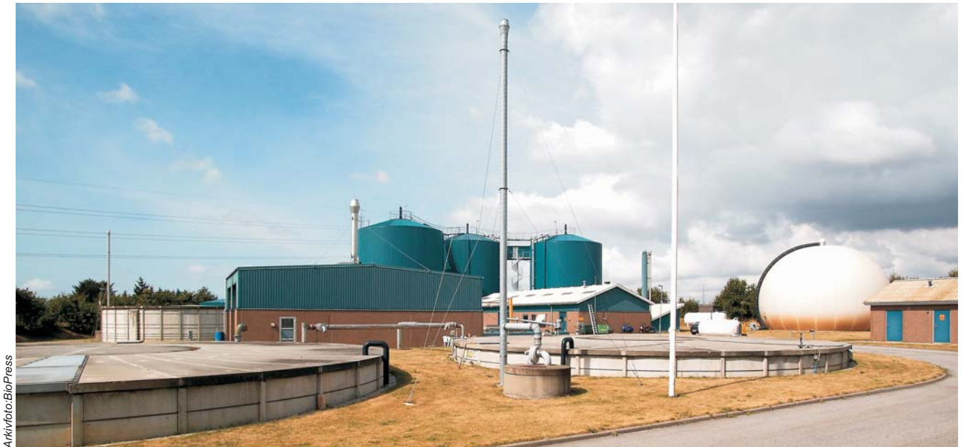
Ribe Biogas er et af de anlæg, hvor der er en mærkbar synenergieffekt ved at supplere gylle med halm
