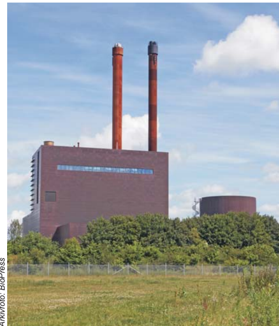
Skive Fjernvarme installerede i 2008 Europas største forgasningsanlæg til kraftvarme med en indfyret effekt på 28 MW. I starten var anlægget præget af en del børnesygdomme, men i dag er driften stabil.
