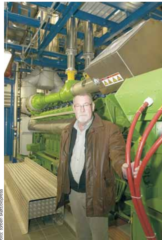
Direktør Benno Jørgensen ved en af de tre gasmotorer, der er koblet til en generator på 1,5 – 2 MW el.
