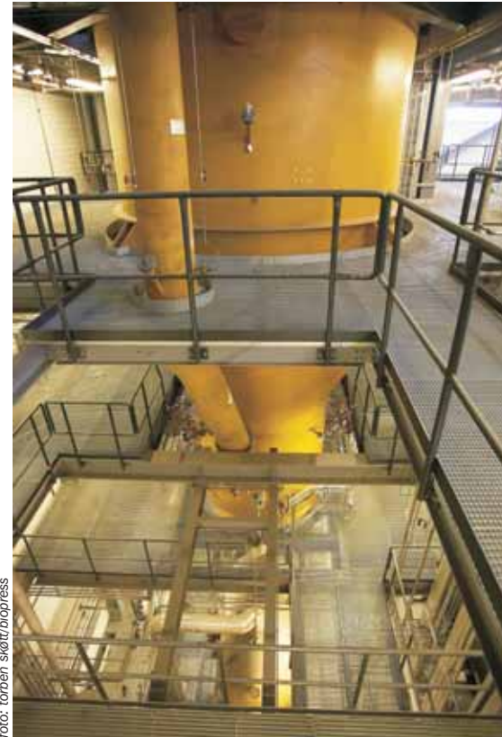
Kernen i anlægget er en fluid bed for-gasser, der på årsbasis skal omdanne 30.000 tons træpiller til gas.
