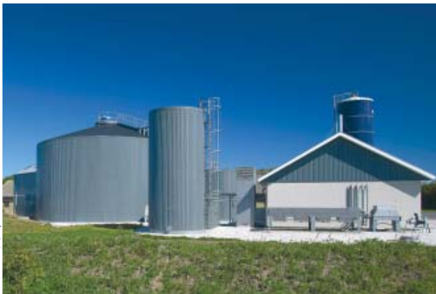
Biogasanlæg hos Grøngas ved Hjørring. Ud over gylle får anlægget tilført forskellige former for energiafgrøder som majs og græs.
