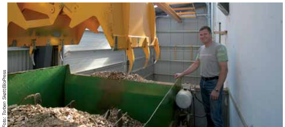
Driftsleder Torben Brand Andersen ved kranen, der forsyner såvel forgasser som kedel med skovflis.
