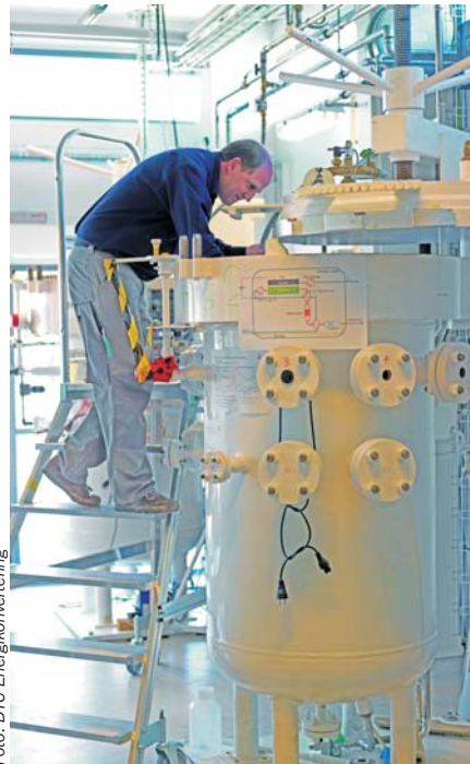
Foto: DTU Energikonvertering
