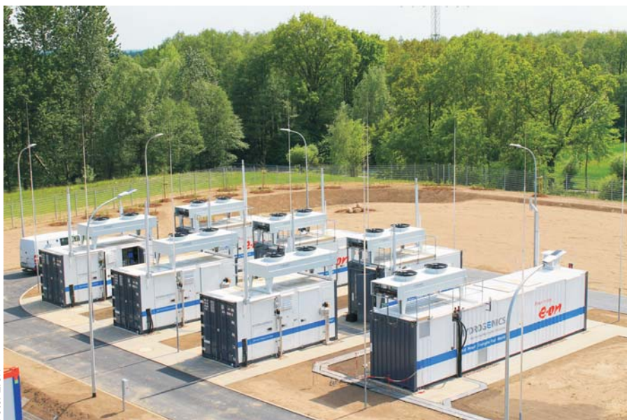
Energiselskabet E.ON har siden 2013 haft et elektrolyseanlæg i Falkenberg i Tyskland, hvor brint sendes direkte ind på naturgasnettet. Anlægget kan producere 360 m 3 brint i timen.
