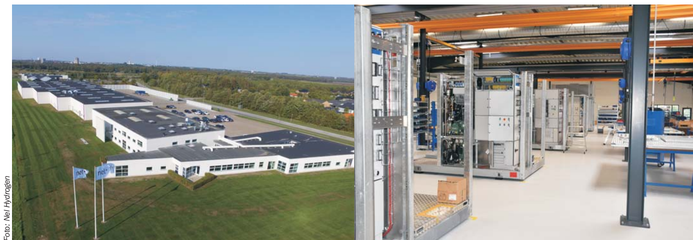
På NEL Hydrogens fabrik i Herning kan der produceres 300 brinttankstationer om året. Det gør fabrikken til verdens største produktionsenhed til fremstilling af brinttankstationer.
