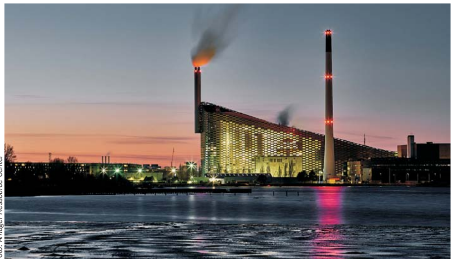
Foto: Amager Resource Center
