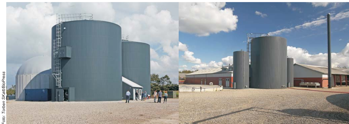
Til venstre: Demonstrationsanlæg hos Combigas, syd for Skjern, opført med støtte fra EUDP. Til højre biogasanlæg på gården Hegndal, der tidligere blev drevet af Kent Skaaning. Begge anlæg og to helt nye anlæg vil til næste år blive koblet sammen via et lokalt biogasnet. På anlægget hos Combigas bliver der etableret et opgraderingsanlæg, så gassen kan distribueres via naturgasnettet.
